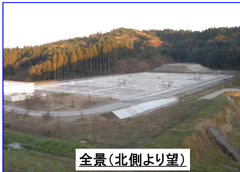
浸出水調整池完成
