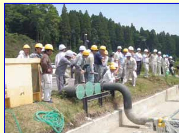
現場説明状況
