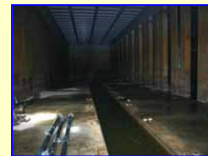
第1-1水槽内部の配管撤去後の写真です。
