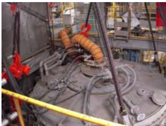
写真 1 安全対策工事の状況①
