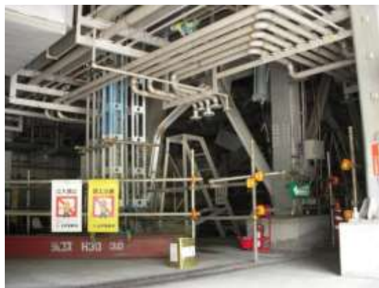
写真 2 安全対策工事の状況②
