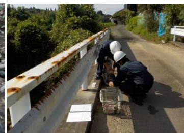
石崎川無名橋
