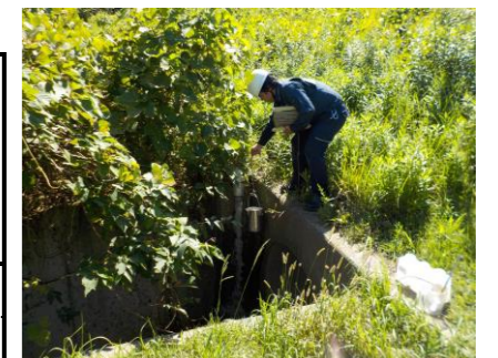
浸出水調整池地下水
