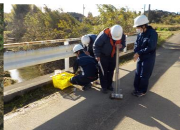
石崎川無名橋
