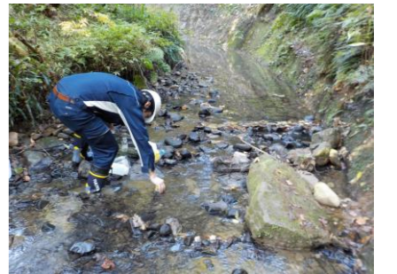
防災調整池排水（敷地境界）
