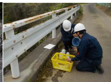
石崎川無名橋
