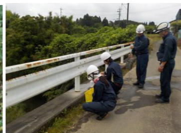
石崎川無名橋
