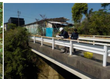
石崎川無名橋
