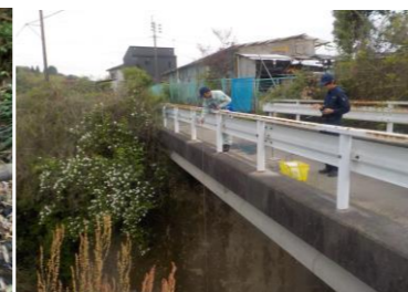
石崎川無名橋
