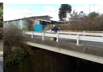
石崎川無名橋
