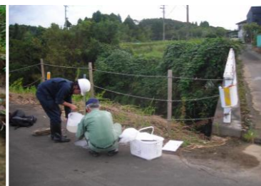
石崎川無名橋
