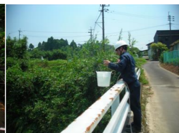
石崎川無名橋
