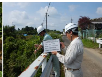
石崎川無名橋
