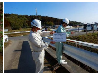
石崎川無名橋
