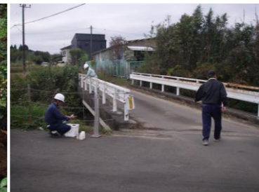
石崎川無名橋
