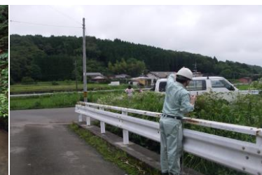
石崎川無名橋
