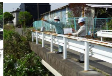
石崎川無名橋
