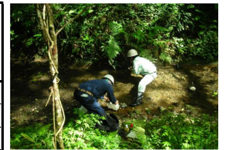
防災調整池排水（敷地境界）
