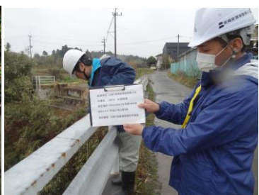
石崎川無名橋
