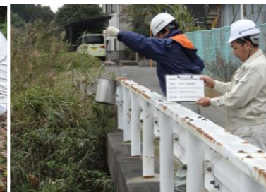
石崎川無名橋
