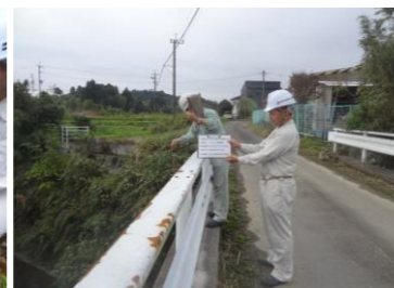
石崎川無名橋
