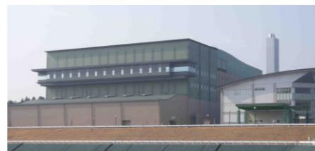
焼却溶融施設
