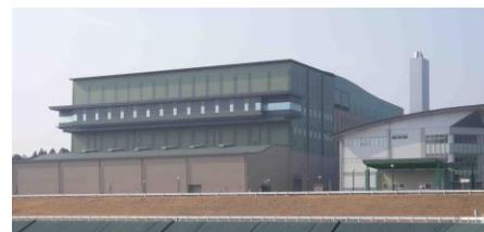
焼却溶融施設
