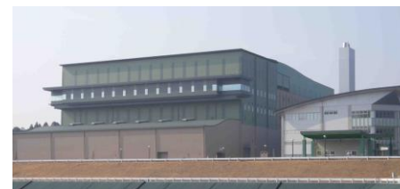
焼却溶融施設
