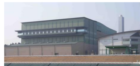
焼却溶融施設
