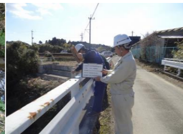
石崎川無名橋
