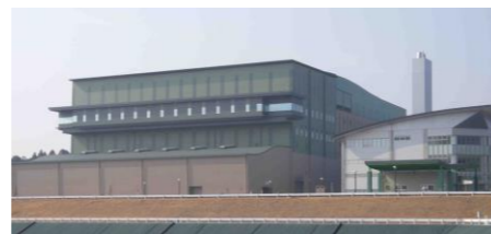
焼却溶融施設
