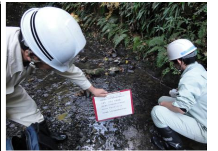
防災調整池排水（敷地境界）
