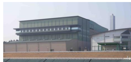
焼却溶融施設
