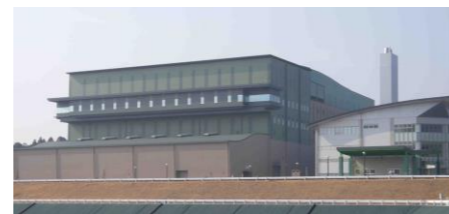
焼却溶融施設
