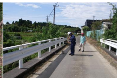
石崎川無名橋
