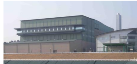
焼却溶融施設
