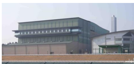
焼却溶融施設
