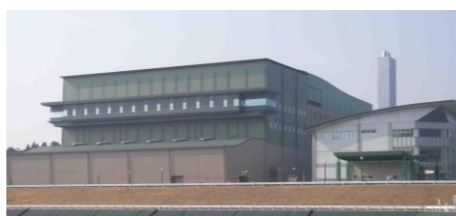
焼却溶融施設
