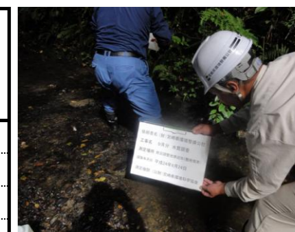
防災調整池排水（敷地境界）
