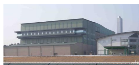
焼却溶融施設
