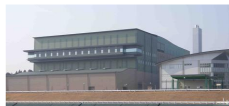
焼却溶融施設
