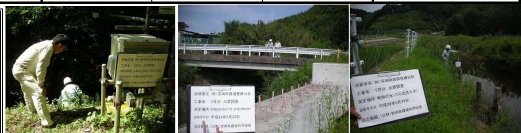
上畑川上流堰 石崎川無名橋 だら池流入水
