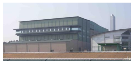
焼却溶融施設
