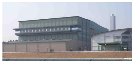
焼却溶融施設
