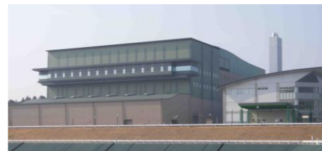
焼却溶融施設
