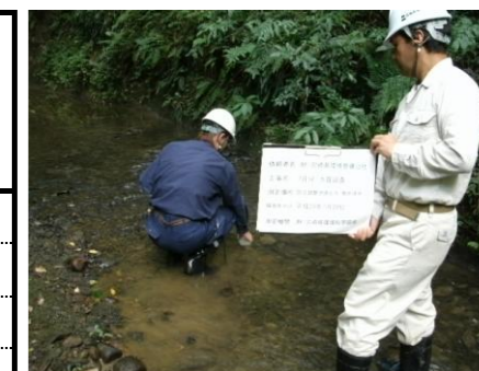
防災調整池排水（敷地境界）
