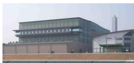
焼却溶融施設
