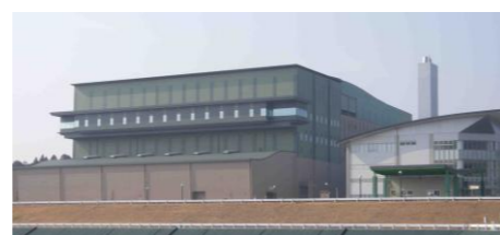
焼却溶融施設
