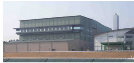
焼却溶融施設
