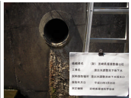
浸出水調整池地下水
