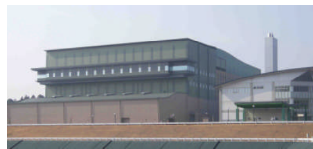
焼却溶融施設
