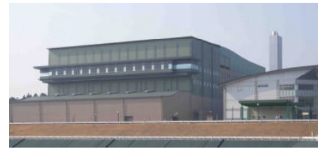
焼却溶融施設
