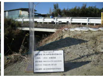
石崎川無名橋
