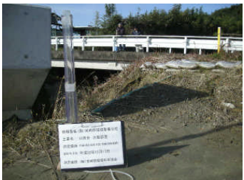
石崎川無名橋
