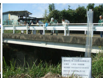
石崎川無名橋
