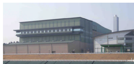
焼却溶融施設
