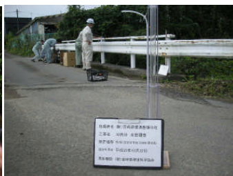
石崎川無名橋
