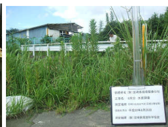
石崎川無名橋
