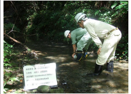
防災調整池排水（敷地境界）
